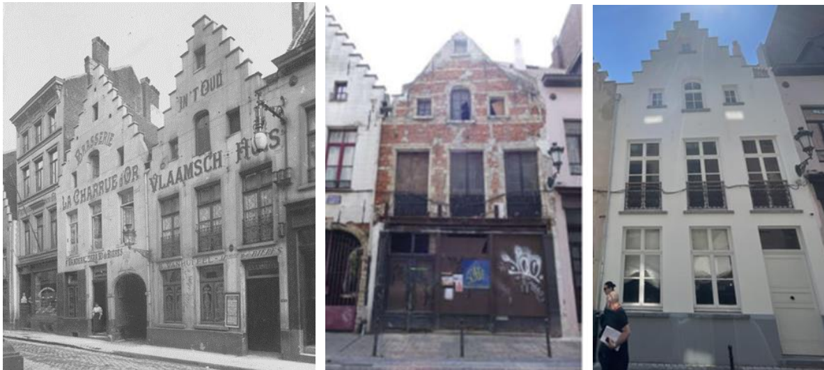
L'ensemble au début du 20 e s. (cliché AVB, ca 1905), l'état avant la restauration de 2019 et la façade actuelle (extr. du dossier de demande)
