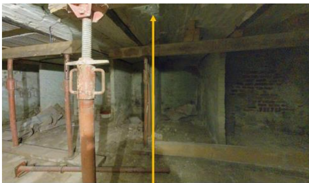
-Voussettes en briques, renfort prévus dans l'étude de stabilité fait par l'ingénieur
