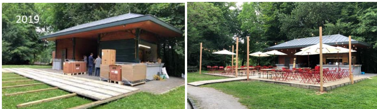
La terrasse mise en œuvre et terminée en 2019 (extr. du dossier de demande précédent)
