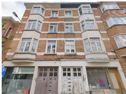
Photo de la façade à rue des n° 40-42 (à gauche et 44). © Google Street View
