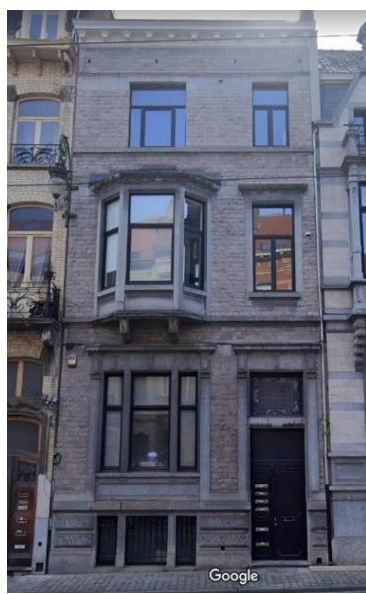
Vue actuelle de la façade avant. ©Google Street View
