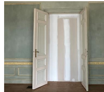
Dubbele houten deur tussen de salons – foto KCML aug.2024
