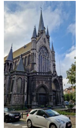
Vue de l'église à front du boulevard du Jubilé. Photo CRMS 2024
