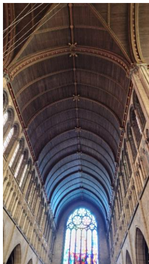
Voûtes en chêne lambrissé
