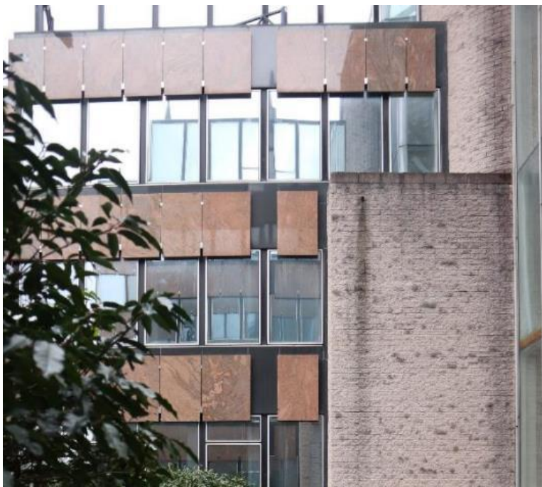
Détail des façades des espaces de bureaux et des parties aveugles, recouvertes respectivement de granit en provenance des Indes et de briques roses (© urban.brussels)
