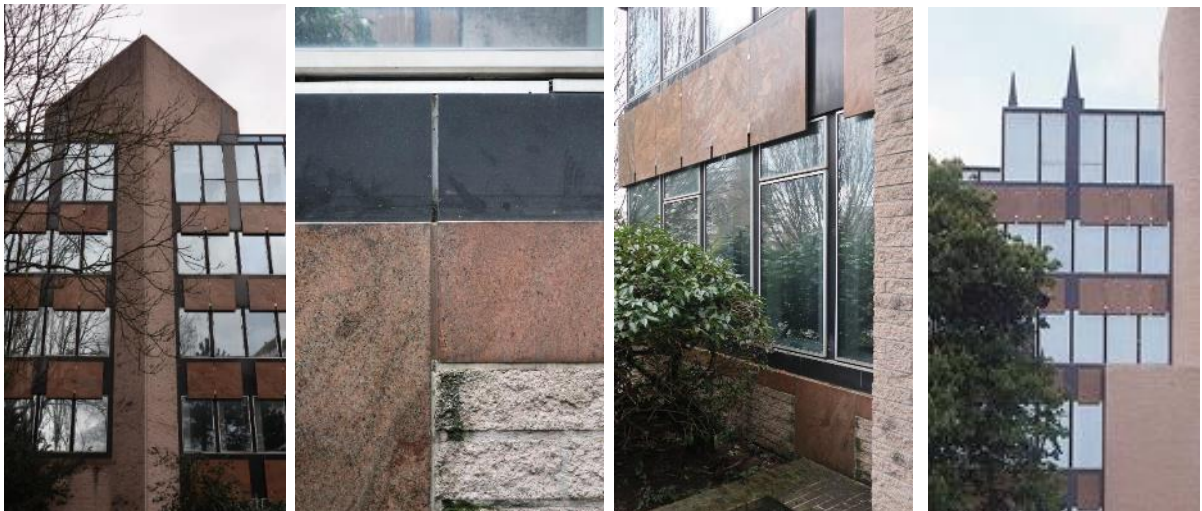
Détails des façades et du choix de matériaux particulier (© urban.brussels)
