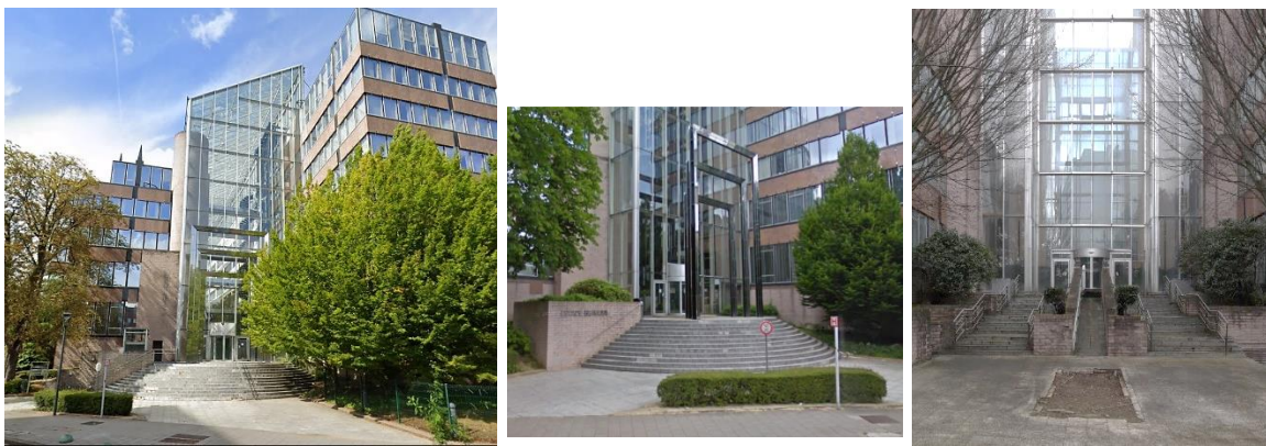
Entrée principale précédée de son escalier arrondi et du portail et entrée secondaire avec ses escaliers et rampe d'accès (© urban.brussels)
