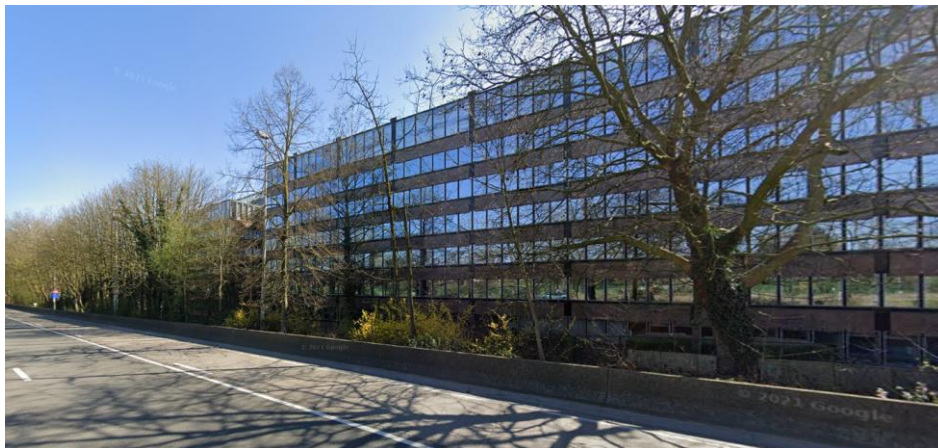
Façades donnant vers l'avenue de Beaulieu (photo du dessus © Atelier d'Architecture de Genva) et tournées vers la E411 (photo du dessous © Google Streetview)
