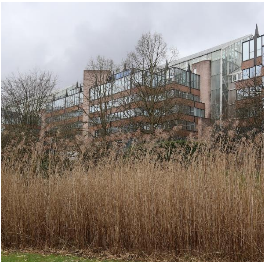
Vue sur les façades 'avant' depuis le jardin qui entoure les immeubles (© urban.brussels)
