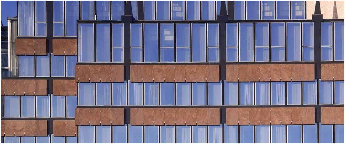
(© Atelier d'Architecture de Genval)
