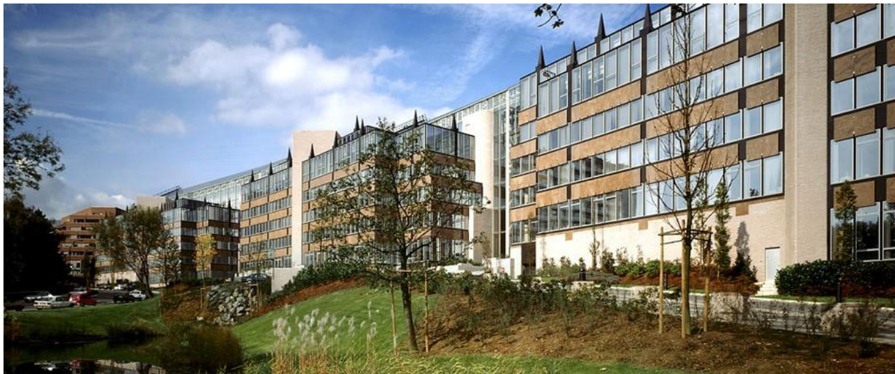
Perspectives sur l'Espace Beaulieu et ses abords depuis l'avenue de Beaulieu (©Atelier d'Architecture de Genval)
