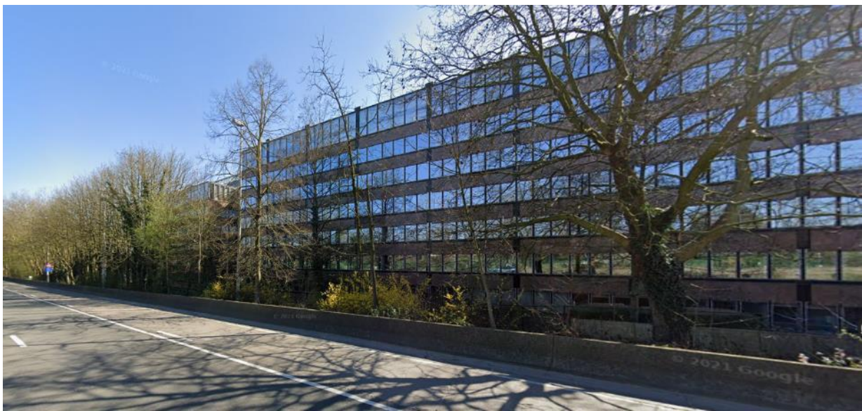
Façades donnant vers l'autoroute E411
