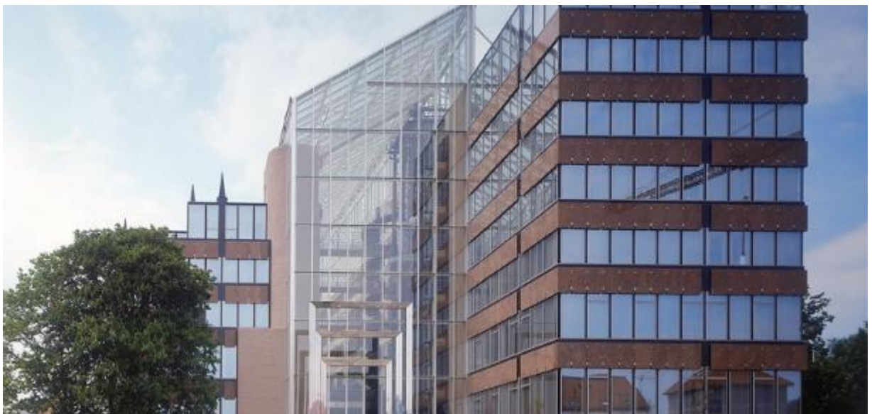
Entrée principale donnant vers la rue intérieure, précédée du portail composé d'éléments en acier inoxydable (© Atelier d'Architecture de Genval)
