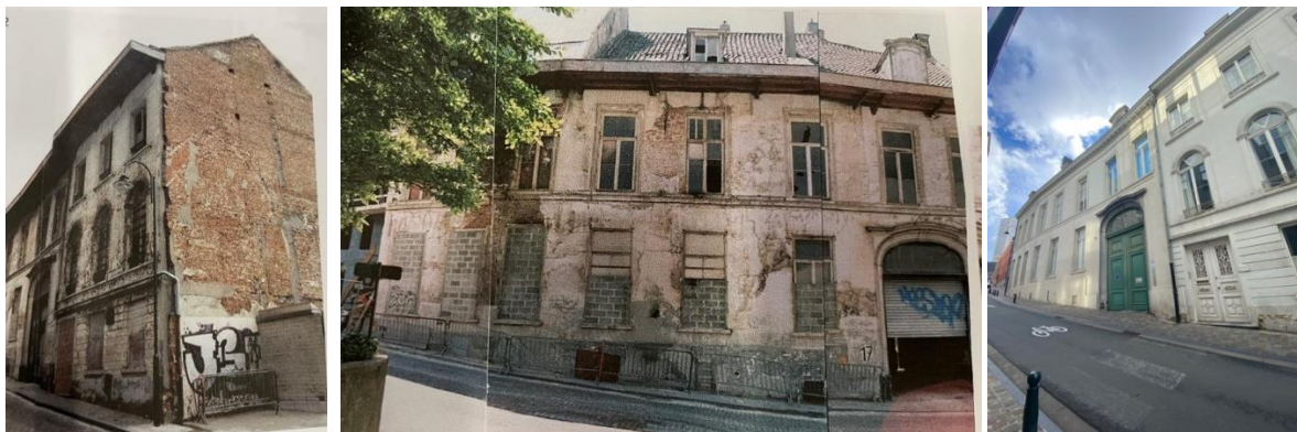
Les bâtiments avant les travaux globales de restauration ( non datés, dossier CRMS ) et situation actuelle
