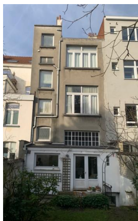
Photo de la façade arrière
