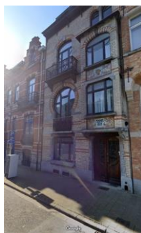
Vue de la maison classée, sise n°110 Avenue Broustin. ©Google Street View
