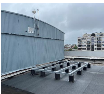
Vue de la structure existante réutilisée en toiture pour le placement des PAC (Photo DPC) Coupe en situation projetée (Extrait demande PU)
