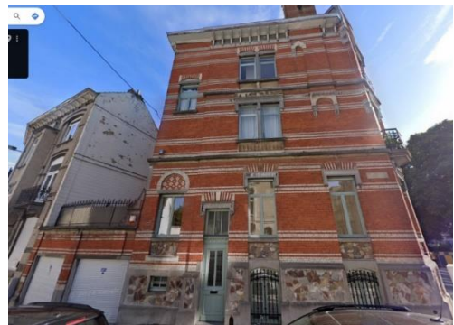
Façade Rue de la Pacification. Photo existante 2024 ©Google Street View
