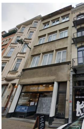
Photo de la façade à rue ©Google Street View
