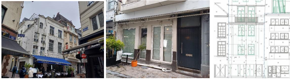
Situation janvier 2025 (photos CRMS). A droite, façade avant projetée (extrait du dossier)
