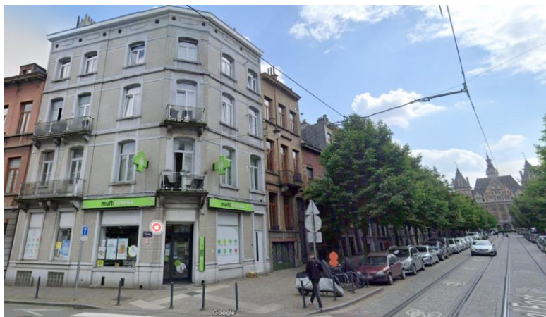
Vue de l'immeuble, à l'angle, et de la maison communale de Schaerbeek. Image @google Street View
