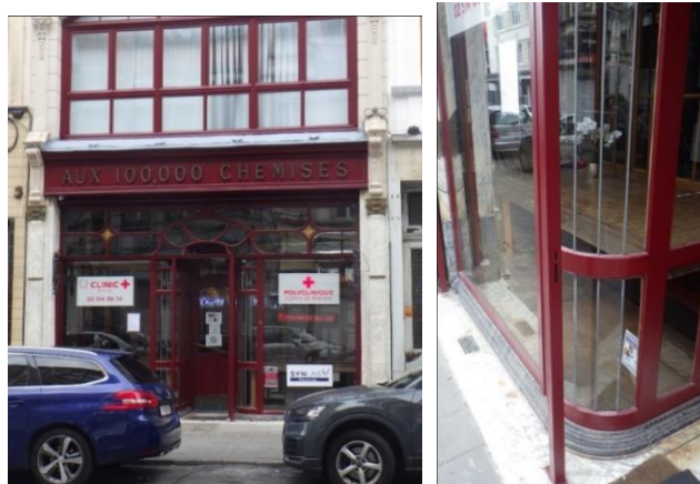
Photos de la devanture prise en juillet 2024 par l'ISA montrant que la grille de sécurité a été déposée mais une partie de sa structure est maintenue (extraits du dossier)
