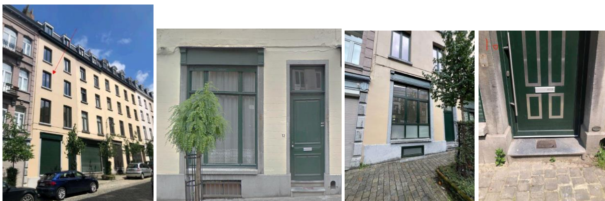
Situation existante des façades, châssis et porte anciennes et existantes du n° 8, porte du n° 10 (© Google Streetview)
