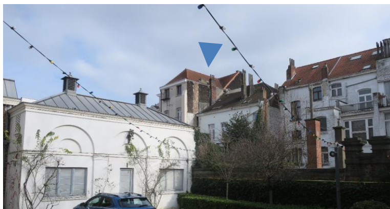
Vue des toitures arrière du 159, chaussée de Haecht visibles depuis la cour de la Maison des Arts (photo CRMS, février 2025)
