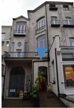
Vue de la porte de sortie de l'office donnant sur la façade arrière (extrait du dossier)
