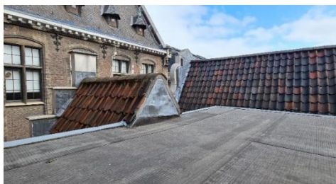
Situation existante : toiture à versants partiellement conservée et toit plat datant de 1957. Photographie extraite du dossier.
