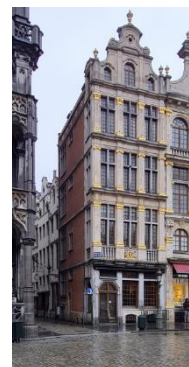
Façade sur la Grand-Place (photographie extraite de l'état de référence)
