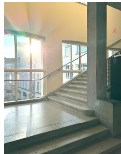
Cage d'escalier en grès à restituer
