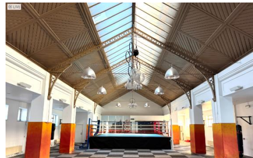
Charpente métallique à démonter et replacer
