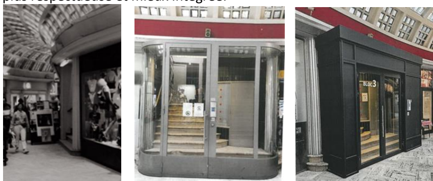
Photo historique ( www.monument.heritage.brussels ) – photos du sas supprimé et du nouveau sas placé en infraction (extr. du dossier de demande)
