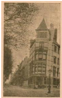
Vue de l'immeuble en 1911. Documentation CRMS.
