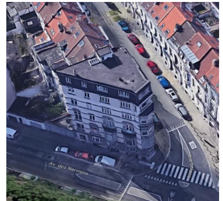
Vue aérienne de la toiture. Google Earth ©
