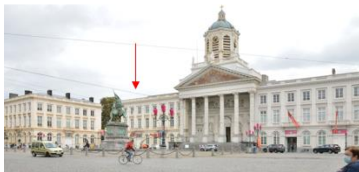
Localisation du n°7 sur la Place Royale (© Inventaire du patrimoine architectural)
