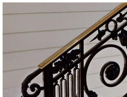
*Profil de la main courante du garde-corps de la seconde volée d'escalier.
