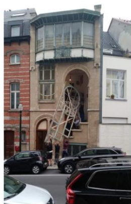
Dépose du châssis de la cage d'escalier pour restauration en atelier, PHASE II des travaux (clôturée).
