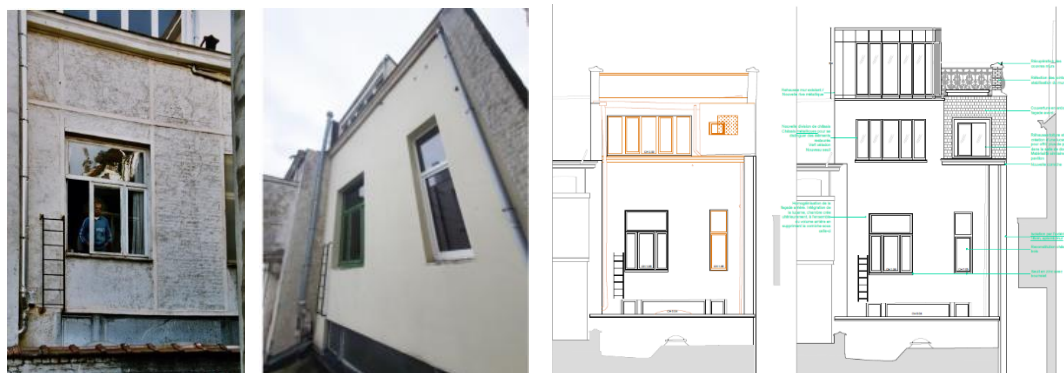
Vue de la façade arrière en 2002 et après les travaux de 2006-2007, élévation existante et projetée (extraits du dossier)
