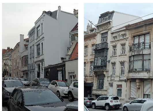
Situation de fait. Photographies CRMS.
