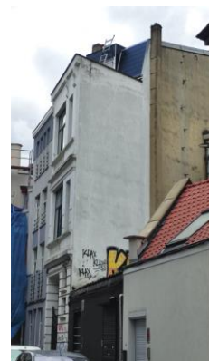
Façade sur la rue de la Poste (doc. extrait du dossier)
