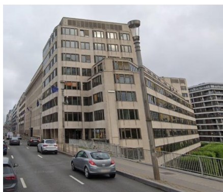
Vue du bâtiment d'angle rue de la Loi 106-108, 130 / chaussée d'Etterbeek 1-15 / rue Joseph II 105-121, œuvre des architectes André et Jean Polak. Photo ©Google Street View
