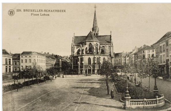
Aménagement historique de la place, avec terre-plein central perméable et massifs plantés. (Carte postale, collection du Crédit Communal, © Académie Royale de Belgique – urban.brussels)
