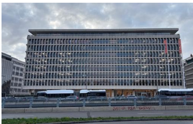
Vue du bâtiment et de l'aile dite Marnix I depuis le boulevard du Régent. Photo CRMS 2026
