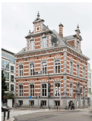
Vue du bien depuis l'angle avenue de la Couronne/avenue Auguste Rodin. Photographie issue du dossier.
