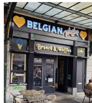
Vue de la devanture existante du n°36. Photo CRMS. Mars 2026
