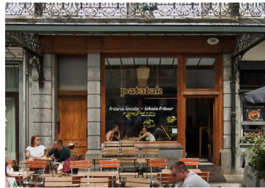
Devanture commerciale du n°34 rue de la Bourse, après travaux de restitution de la devanture. Photo ©Google Street View
