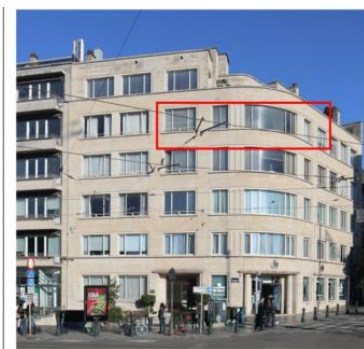
Situation avant le remplacement des fenêtres
