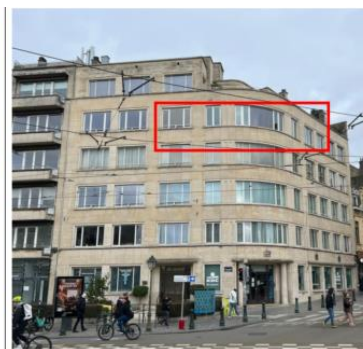
Situation après le remplacement des fenêtres. Images extraites du dossier
