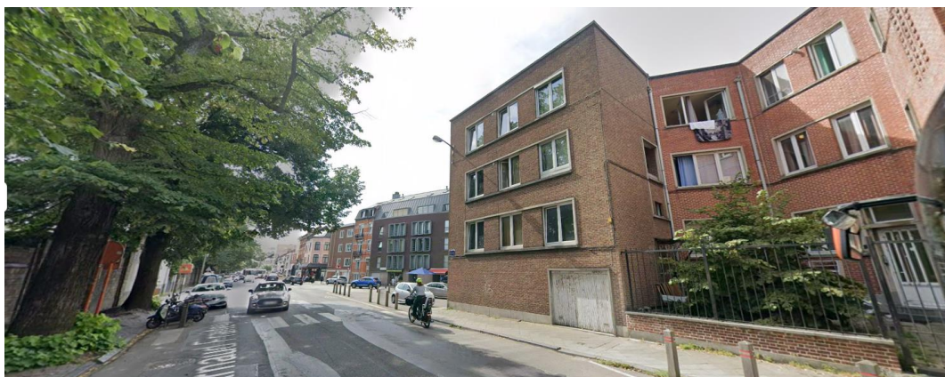
Vue actuelle des blocs 1 et 2 (à droite) et 3 de part et d'autre de la courette donnant sur l'avenue Arnaud Fraiteur, en face du mur du cimetière d'Ixelles (© Google maps)
