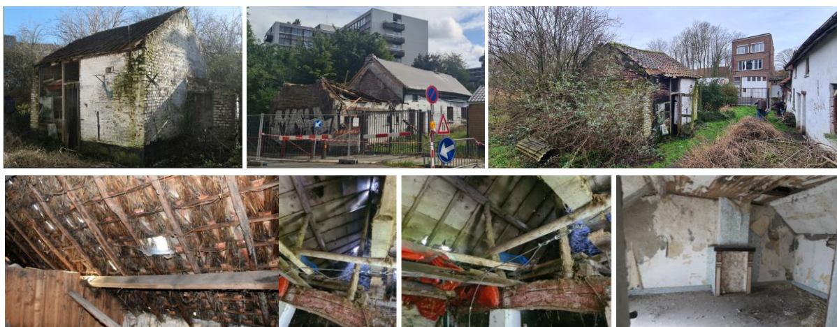
État actuel du bâtiment (extrait du dossier)
