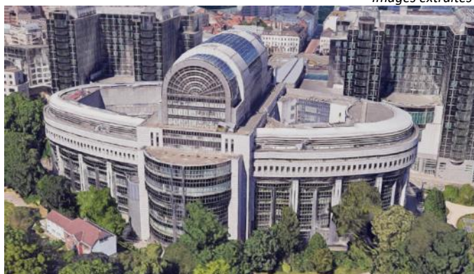
Façade donnant sur le parc Léopold – Situation existante.
