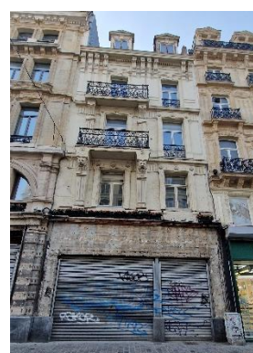
Immeuble rue des Fripiers 36. Photo CRMS avril 2026
