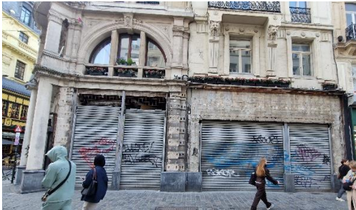
Situation existante. Photo CRMS avril 2026
