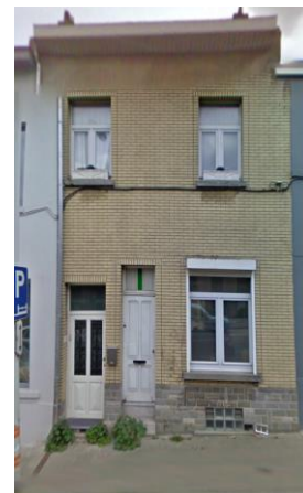
Photo de la façade à rue ©Google Street View
