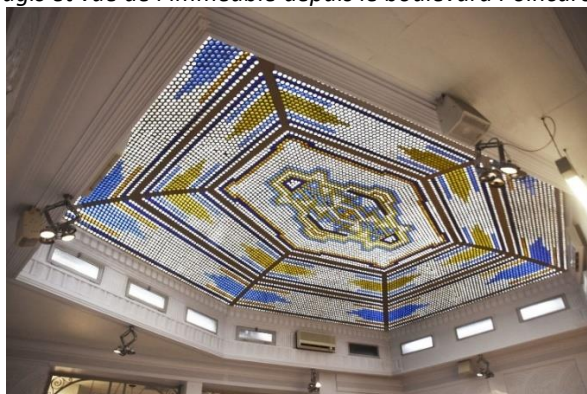
Vue de la coupole et ses 13.000 pavés translucides fabriqués par les Cristalleries du Val-Saint-Lambert (extrait du dossier)
