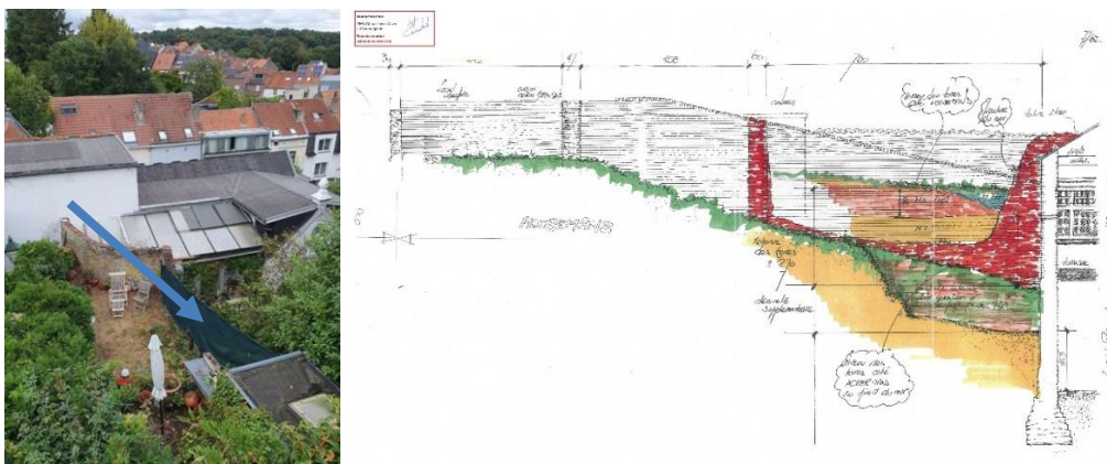
Vue du mur effondré. A droite, profil pédologique réalisé en 2007 par la DPC localisant le remblai H1 (antérieur aux années '60) et les remblais H2 et H3 des années '70 (extraits du dossier)
