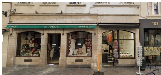
Devanture réalisée selon le permis de 1991, dans son état de 2021 (© Google Street View)
