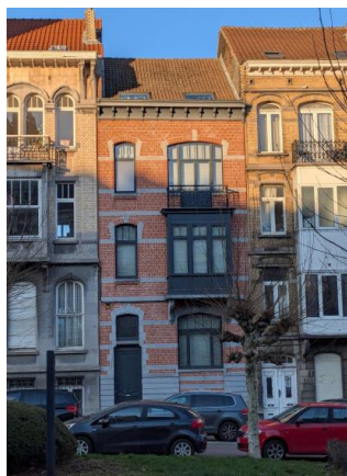
Photo de l'immeuble extraite du dossier.
