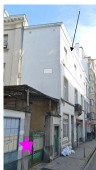
Localisation du bien © Google Maps Street View
