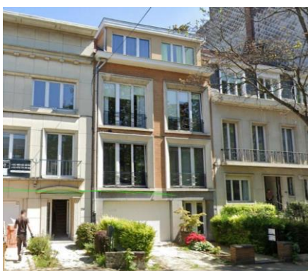
Photo de la façade sur rue, extraite de la demande
