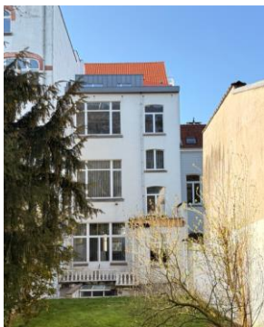
Photo de la façade arrière existante. Extrait du dossier.
