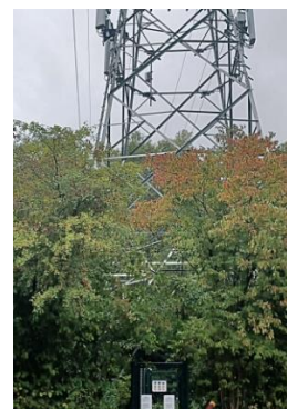
Vue du portail d'accès à la zone technique depuis la rue du Zuen
