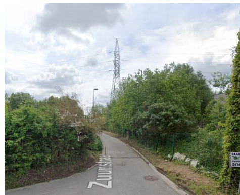
Vue du pylône depuis la rue de Zuen. Photo ©Google Street View
