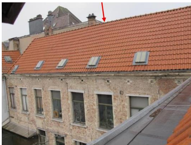
Vue depuis la tabatière de l'ensemble classé rue des Grands Carmes 20. En rouge, localisation de la hotte. Photo ©Urban.brussels
