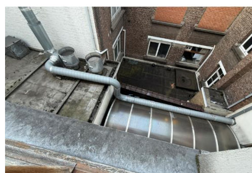
Photos du conduit de hotte actuel.
