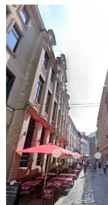
Photo de la façade avant en direction de l'immeuble voisin, classé lui aussi. ©Google Street View
