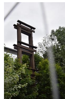
Structure métallique présente sur le site Bordet (photo CRMS)
