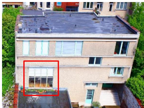
Façade avant du bien. La baie éclairant le séjour est entourée en rouge sur la photo. Elle est équipée d'un châssis fin en acier, encore pourvu de sa quincaillerie d'origine. Ses divisions ont inspiré l'expression des 3 nouveaux châssis.
